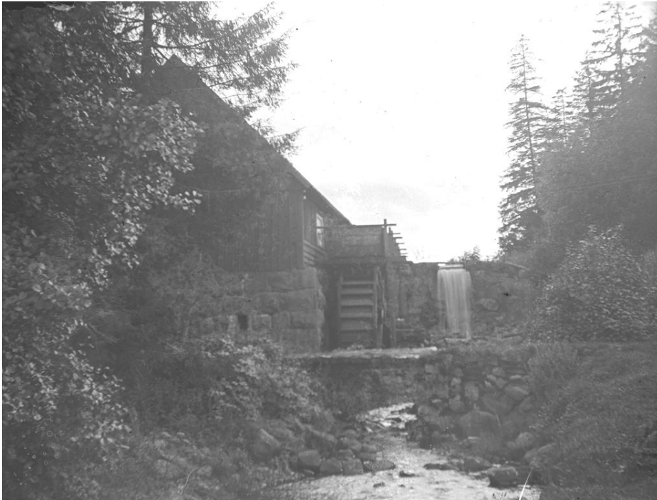
Hallanäs kvarn. Av bilden (203) att döma var detta en så kallad överfallskvarn där vattnet leddes i en ränna så att det träffade vattenhjulet på ovansidan. Brunnsbacka sågkvarn som finns bevarad nära Unnaryd är en underfallskvarn där vattnet i stället sätter fart på vattenhjulet genom att ledas in nertill.
